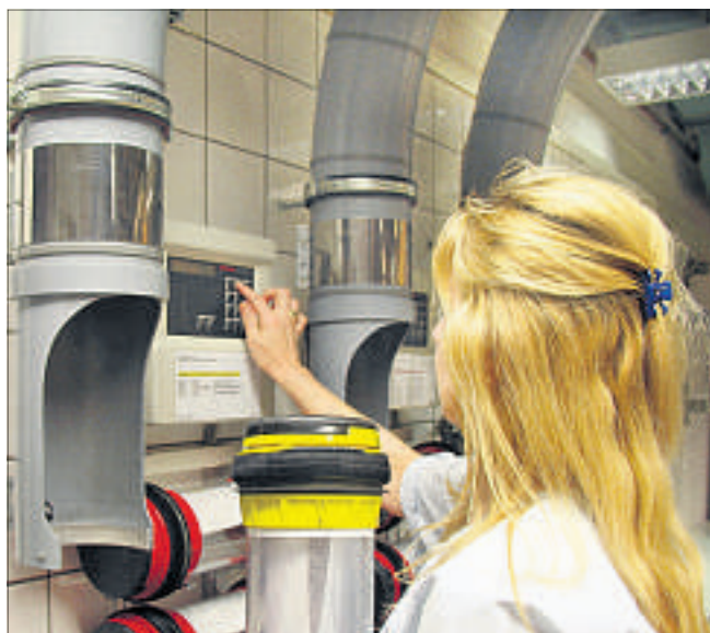
Eine Mitarbeiterin gibt an einer Sendestation der Rohrpost den Zielcode für einen Transport ein. (Foto: OTZ/Clemens)
